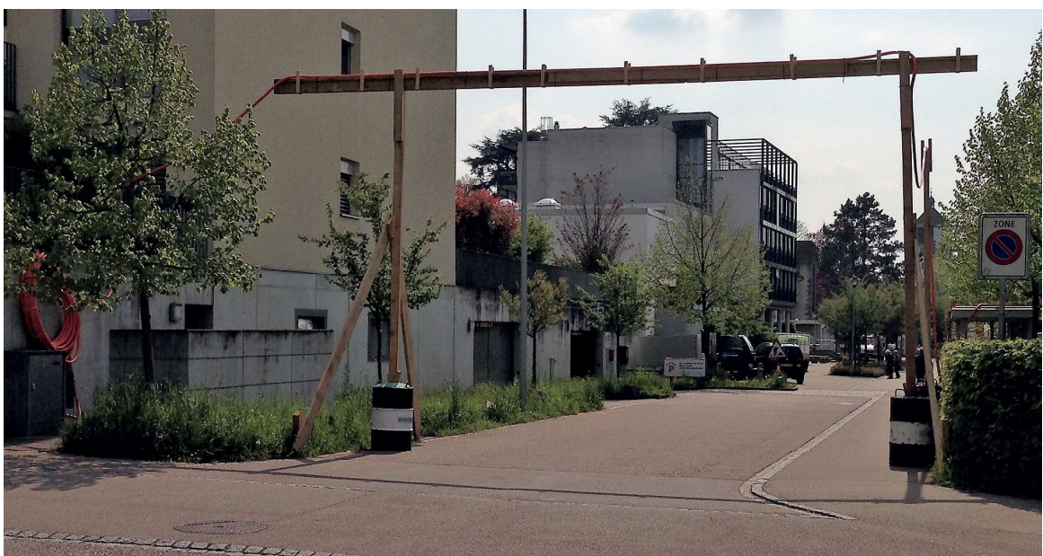
Kabelüberführung bei der VK Parkweg während dem Test mit der Vermaschung
