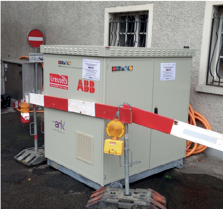
Der mobile Frequenzumformer im Einsatz bei der Verteilkabine VK Johannitergasse in der Altstadt
