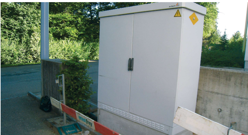
Platzierung des Längsreglers auf einem Betonsockel (zweitüriger Schrank) bei der KK Roberstenstrasse (links grauer Betonkasten bei Kandelaber)
